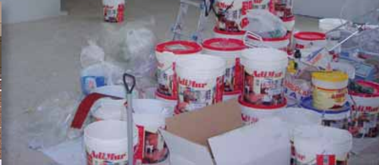
Scuola dell'infanzia via Giordano, lavori di imbiancatura
